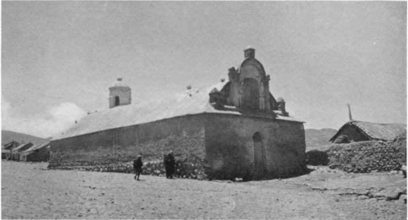
FIG. 29—Old Caja del Agua. Above the entrance door are the words: "Año 1775—El Señor Gobernador do Jaime Saint Just con el Ilustre Cabildo hicieron esta obra, con los fondos pios de esta Villa, siendo Procurador . . ."
